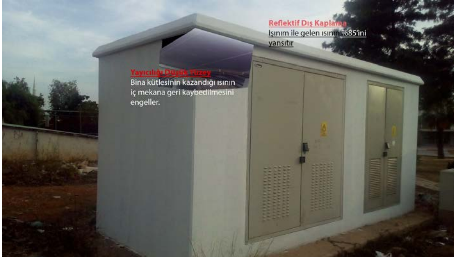
Şekil 2: İç ve Dış Yüzeyleri farklı malzemelerle kaplanmış trafo örneđi
