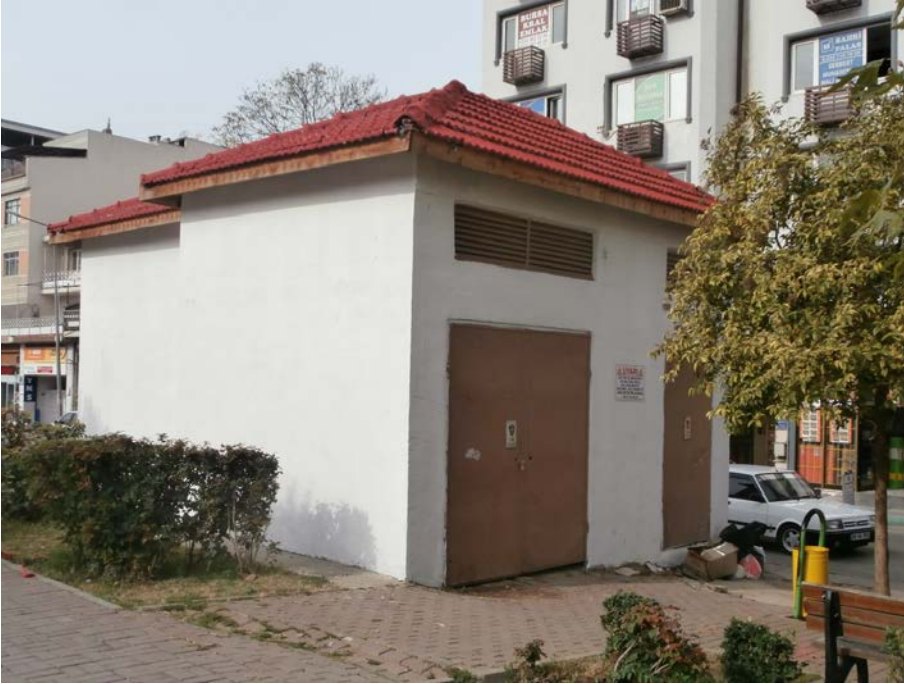
Şekil 22: Osmangazi 66 nolu trafo renkli dış cephe boyası ve renkli reflektif kiremit boyası ile uygulanmış hali
