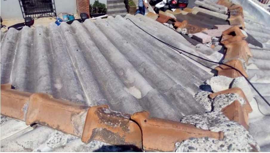
Şekil 9: İstanbul Etiler'de trafonun uygulama öncesi çatı görünümü
