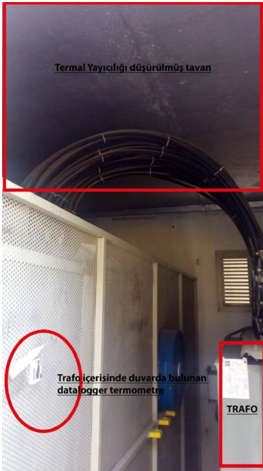
Şekil 27: Trafo İ Görüntüsü ve OG tarafta termometrenin yerleşimi
