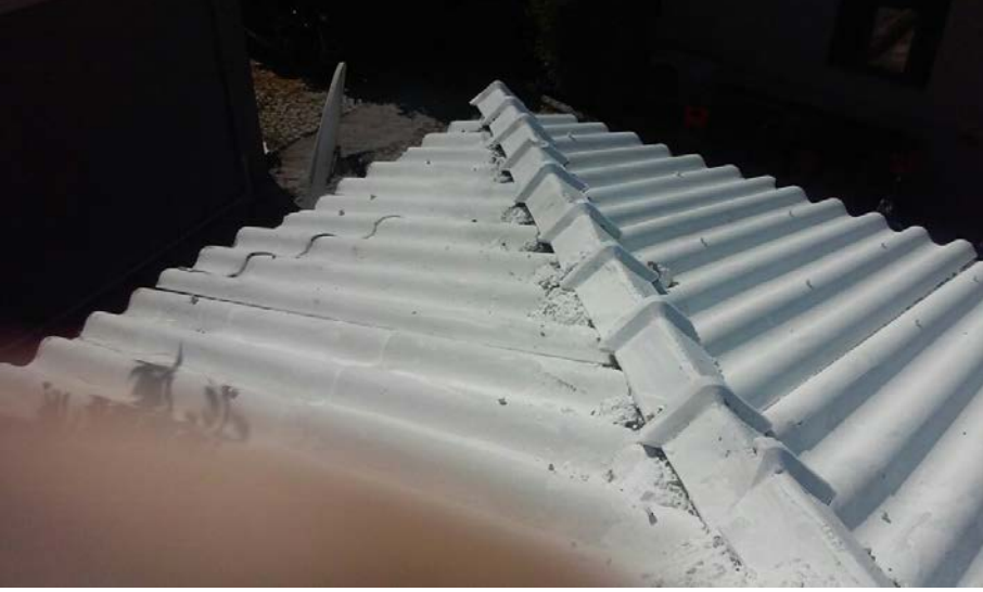
Şekil 10: İstanbul Etiler'de Trafo binası çatısının uygulama sonrası görünümü
