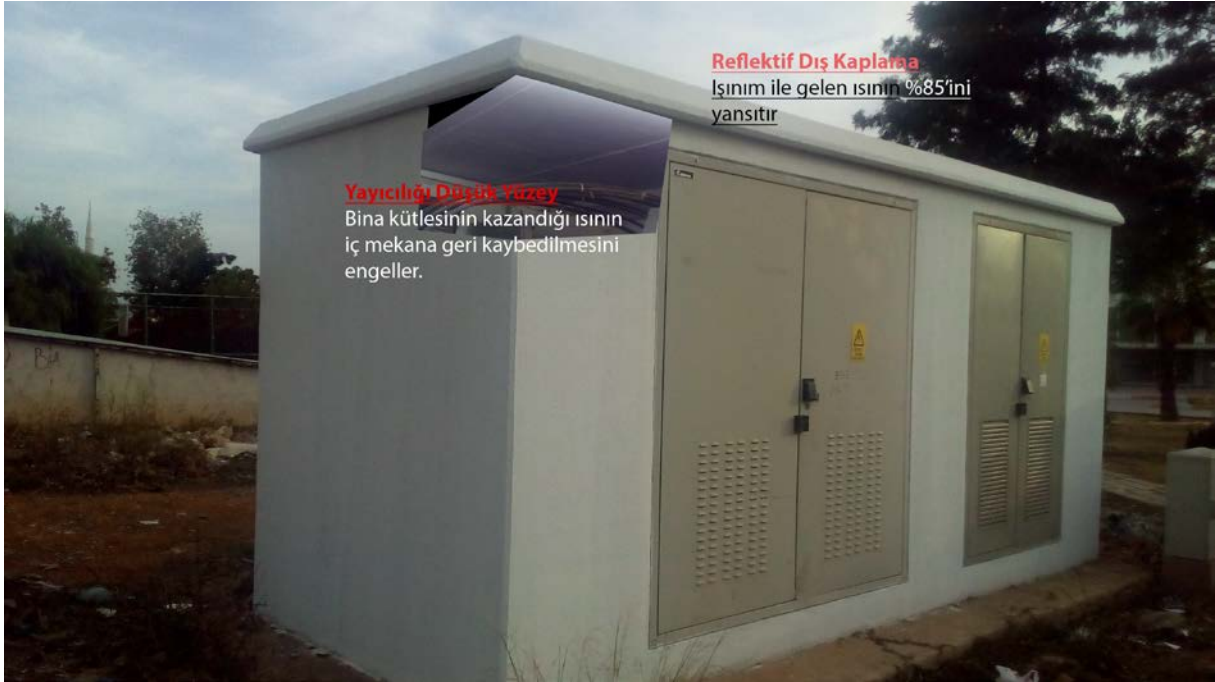
Şekil 1: Bir trafo binasının son hali (Açıklamalı)
