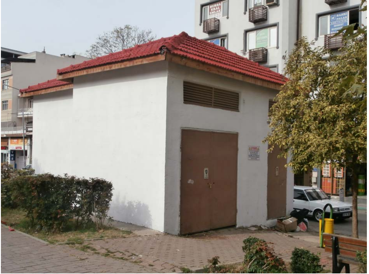
Şekil 2: Çatısı Reflektif Kırmızı ile boyanmış trafo örneği
